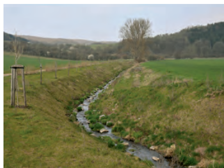
Der Breitunger Bach nach Abschluss der Arbeiten.
