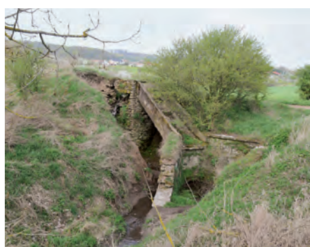
Das ehemalige Abflussbauwerk am Breitunger Bach.
