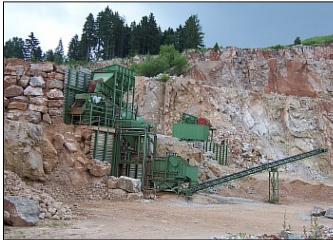
Foto 11: Blick auf die Wasch- und Klassifizierungsanlage (eigene Aufnahme)
