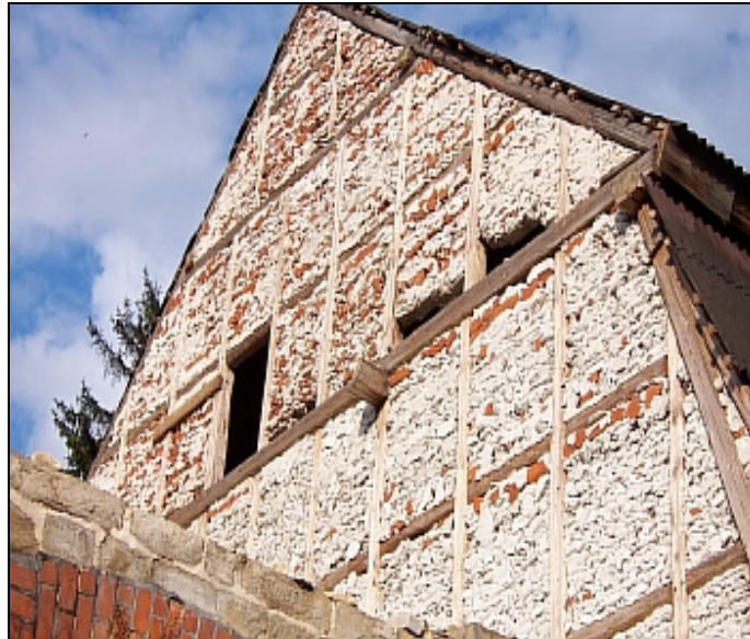
Foto 3: Gefache einer Scheune gefüllt mit Gipsmörtel und Mauersteinen (eigene Aufnahme)
