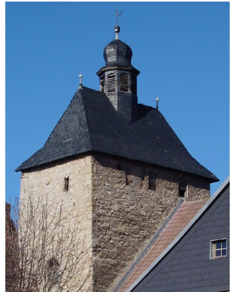
Westturm 24 m hoch mit Walmdach
