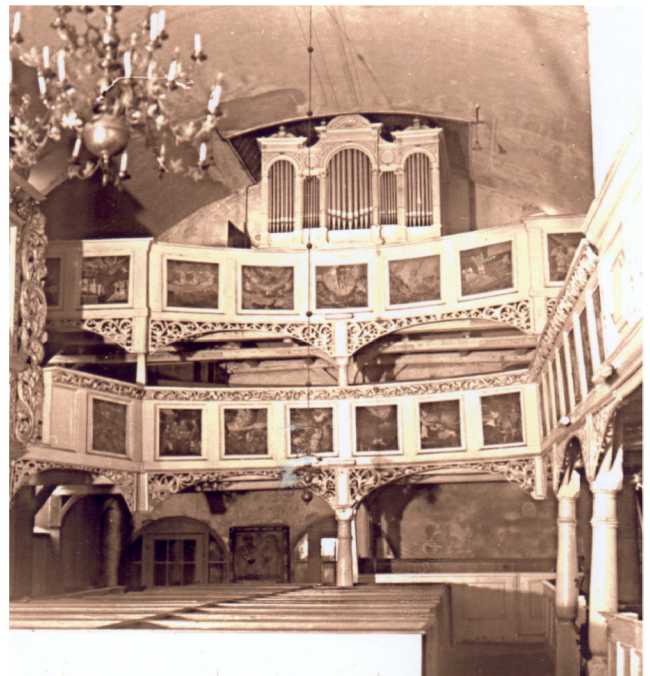
Ansicht der Emporen im ursprünglichem Zustand, Foto vom Pfarramt
