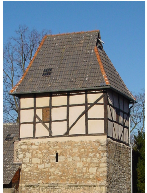
Ostchorturm 14 m hoch mit Walmdach
