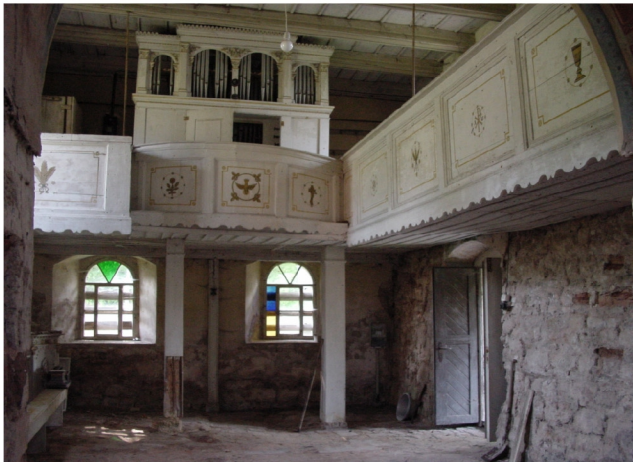
Innenansicht in Richtung Kirchenschiff
