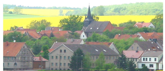
Ortsansicht von Südosten
