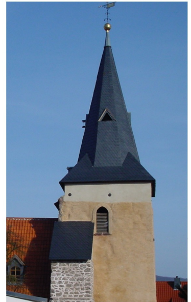
Ostchorturm 20 m hoch mit oktagonalem Turmdach
