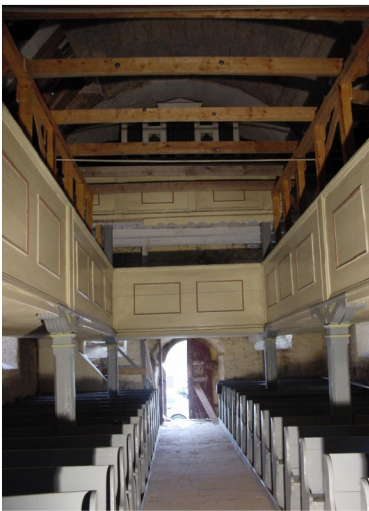
Innenansicht in Richtung Chor
