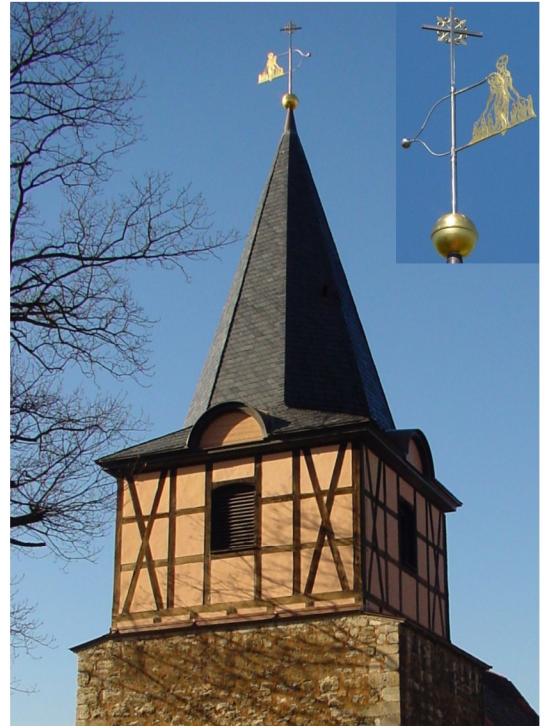
Ostchorturm 23 m hoch mit oktagonalem Turmdach
