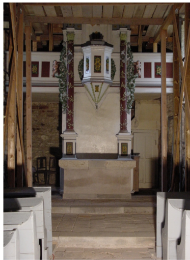
Innenansicht in Richtung Kirchenschiff
