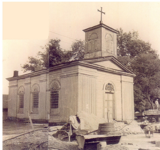
Kirchenansicht von Westen, Foto vom Pfarramt Ilfeld
