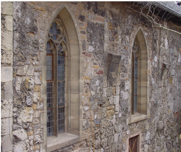
Nordwand mit Gewölbeansätze für das ehemalige Nordschiff
