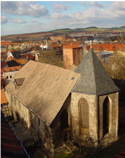
Kirchenansicht von Südosten
