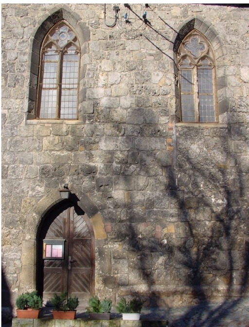
Linkes Südportal und zwei Fenster mit Maßwerk
