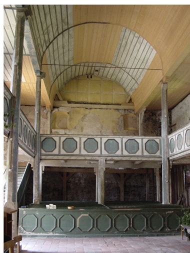
Innenansicht in Richtung Kirchenschiff
