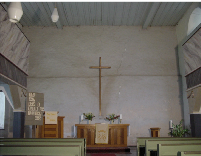
Innenansicht in Richtung Chor
