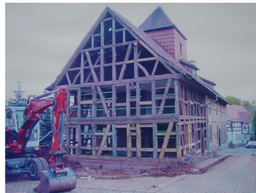
Sanierung von 2000 bis 2001
