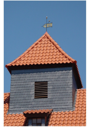
Dachreiterturm 9 m hoch
