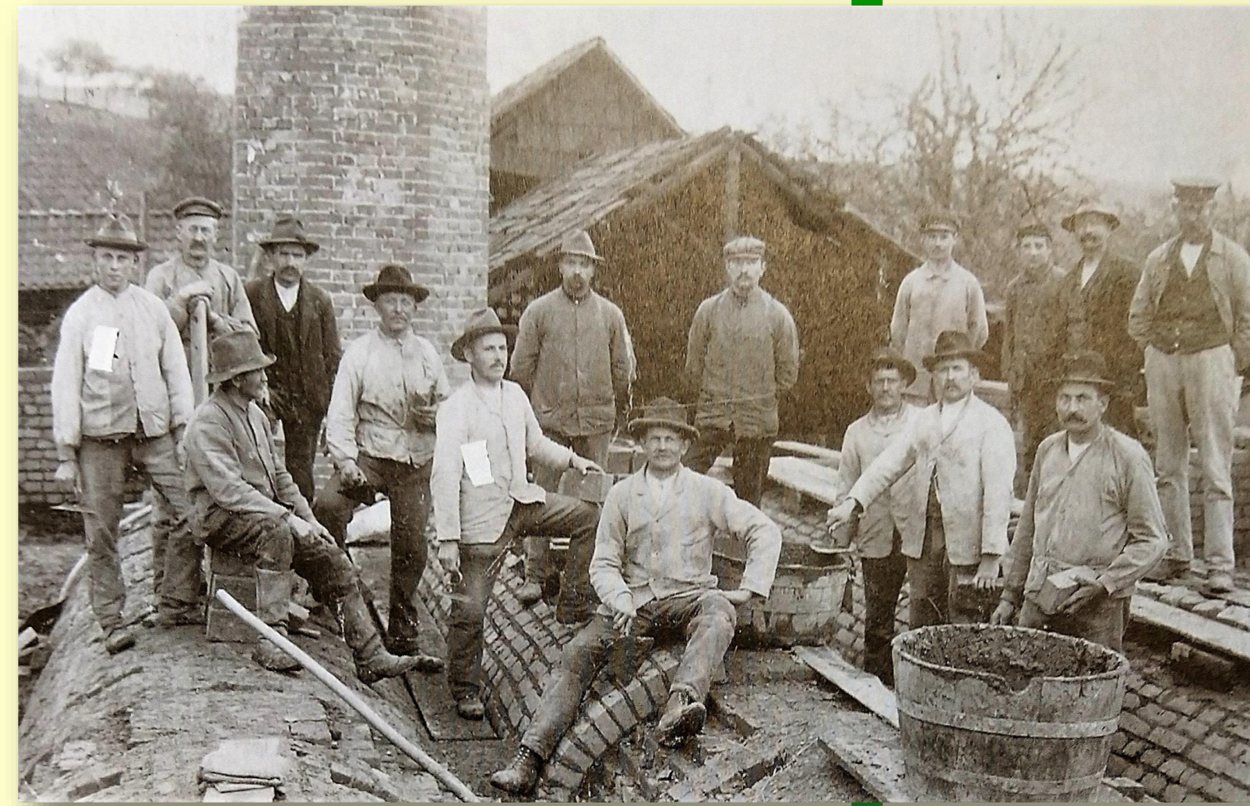
Handwerker ummauern die Brennöfen der Ziegelei von oben.
